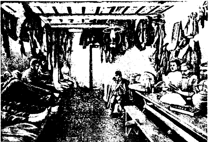
Kaivoksen № 32 kasarmissa. Ruttšenkovon vuoriteollisuusyhtiö. 1900.
