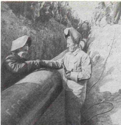
»Družba»-öljyjohdon rakentajien, neuvostoliittolaisen ja tšekkoslovakialaisen sähköhitsaajan kohtaaminen
