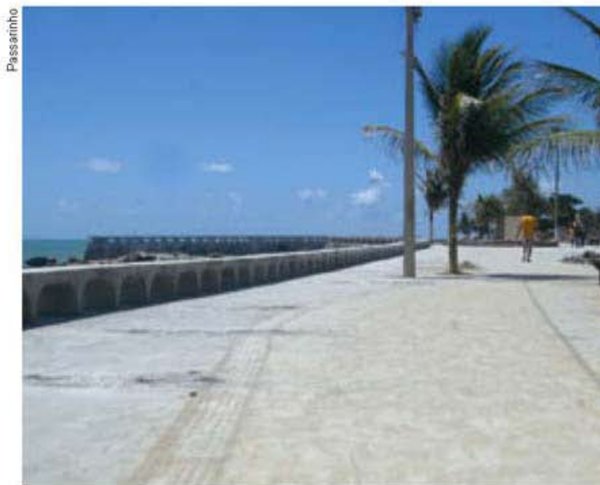
Urbanização de 2,2 quilômetros da orla do Bairro Novo
