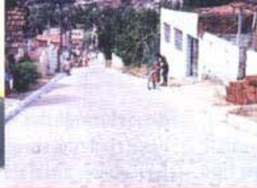
Asfalto e reaparelhamento de ruas
