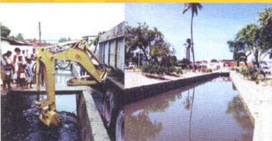
Limpeza de canais
