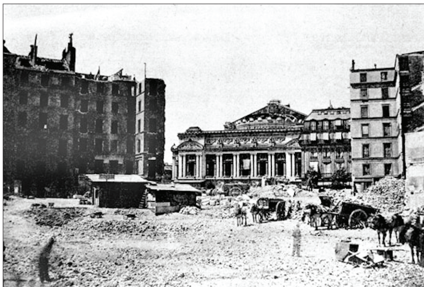
Les travaux boulevard Haussmann jusqu'à l'Opéra.
